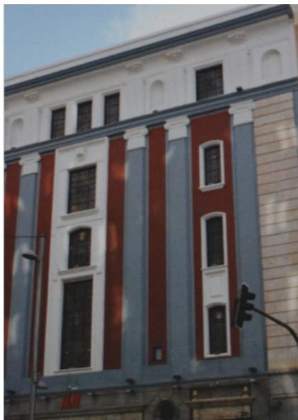
Figura 1. Fachada del antes cine Avenida. Fuente: tomada del libro Madrid cosmopolita (2009).
