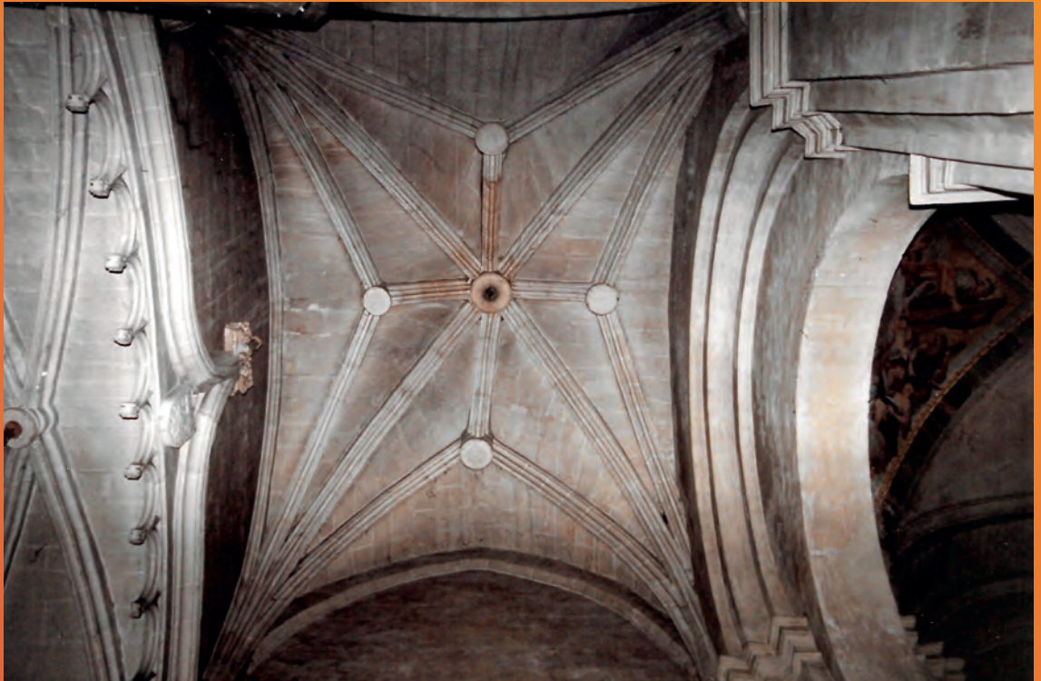
13. Bóveda junto a la capilla de San Marcos en la Iglesia de Santa María de Palacio.
