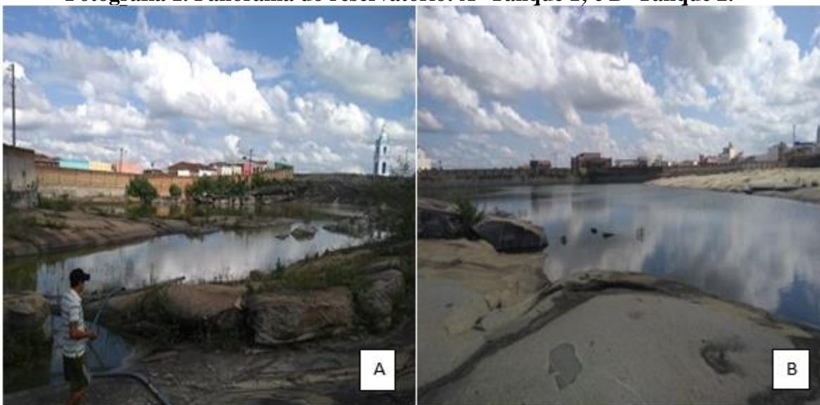
Fotografia 1. Panorama do reservatório: A- Tanque 1; e B- Tanque 2.
