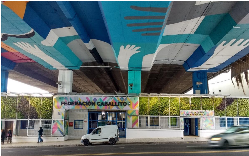
Figura 25. Bajo Autopista Av. La Plata. Obra finalizada 2017.
