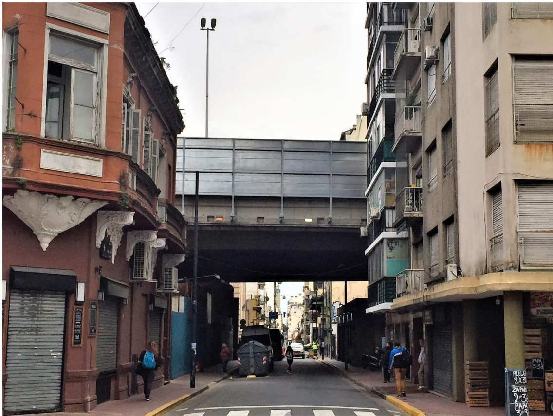
Figura 23. Bajo Autopista de la calle Bolívar.
