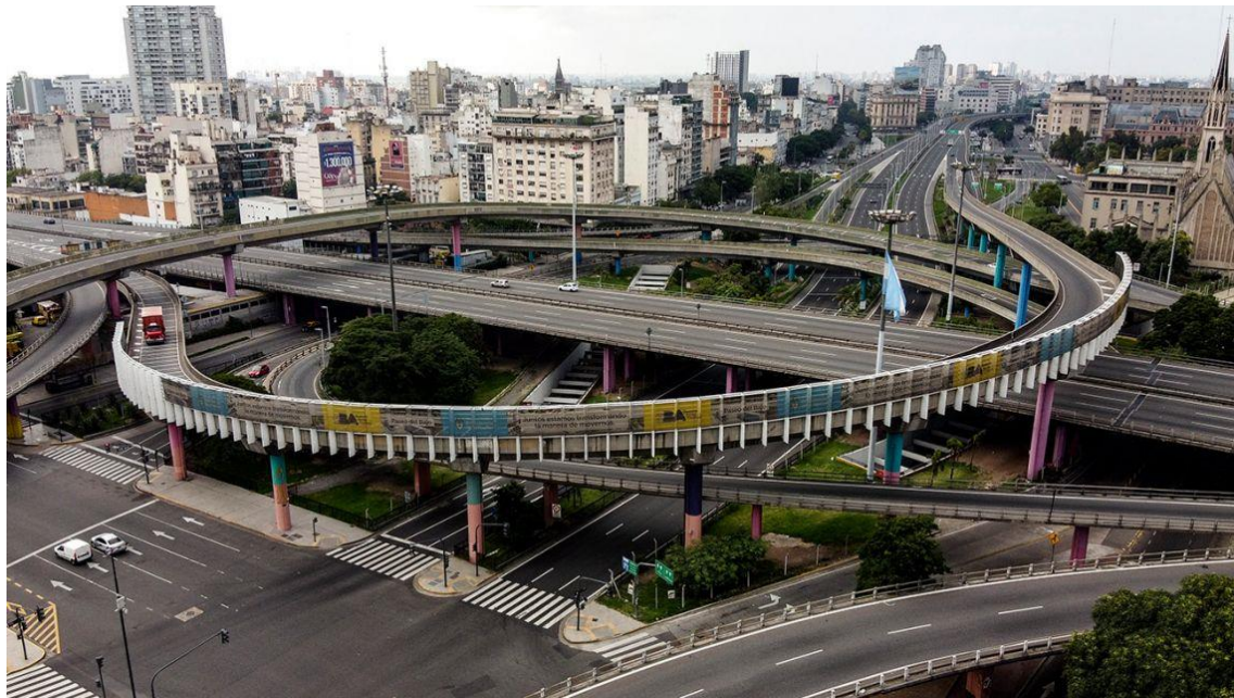
Figura 15. Conector de Autopista 25 de Mayo con Av. 9 de Julio.
