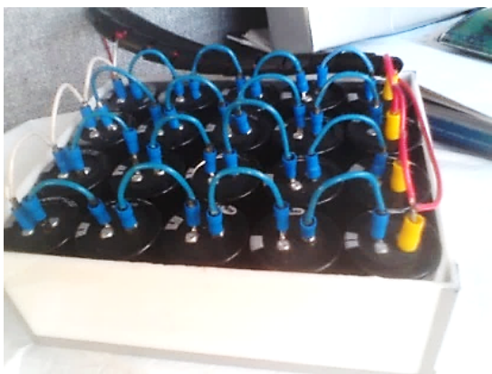
Figura 6: Construcción del banco de ultracondensadores
