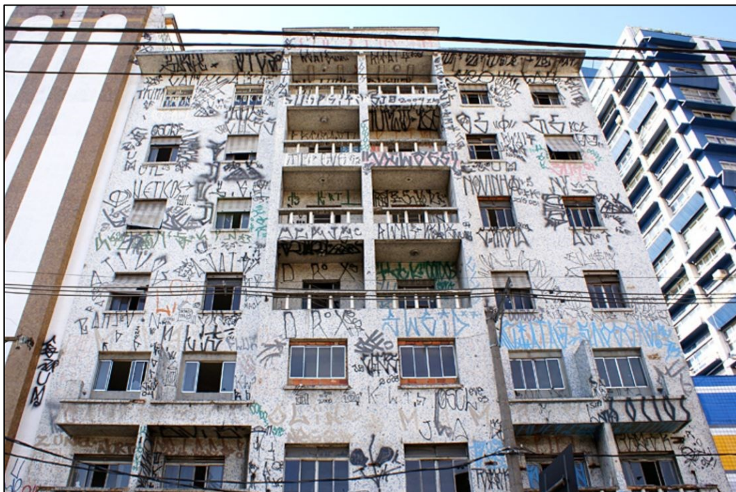
Figura 1 – Edifício Elisa, no Centro de São Paulo, 2010.
