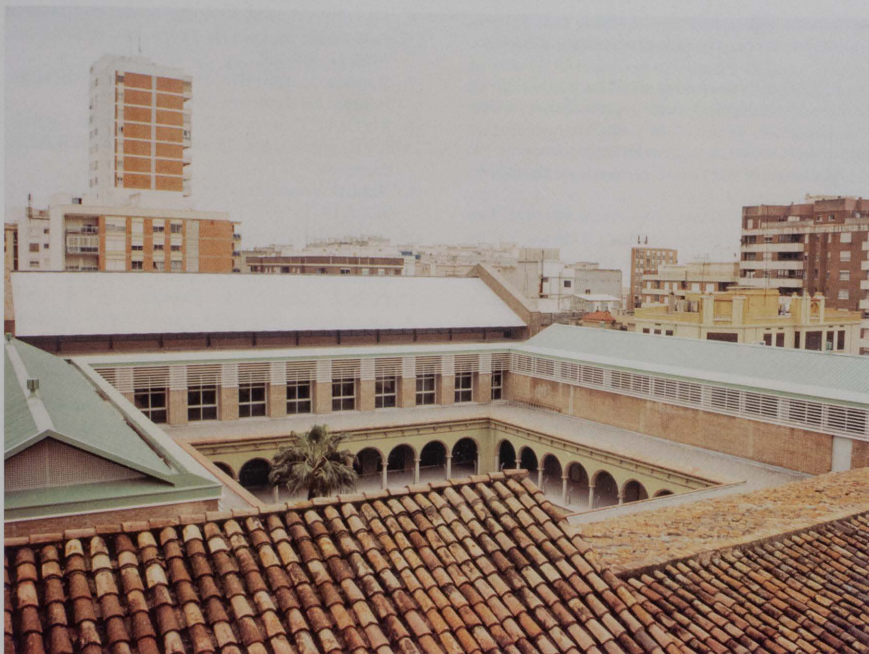
En los años 80 se derribó todo el convento, a excepción de la iglesia y los arcos del claustro. En su lugar se levanta hoy el Conservatorio y la Escuela de Artes y Oficios. Foto Heredio.
