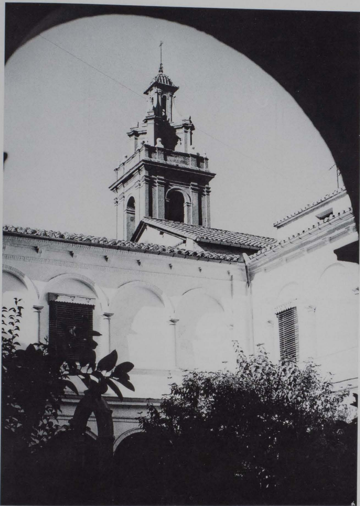
Detalle del sobreclaustro, con el campanario del S. XVIII al fondo Foto Arxiu Diputació
