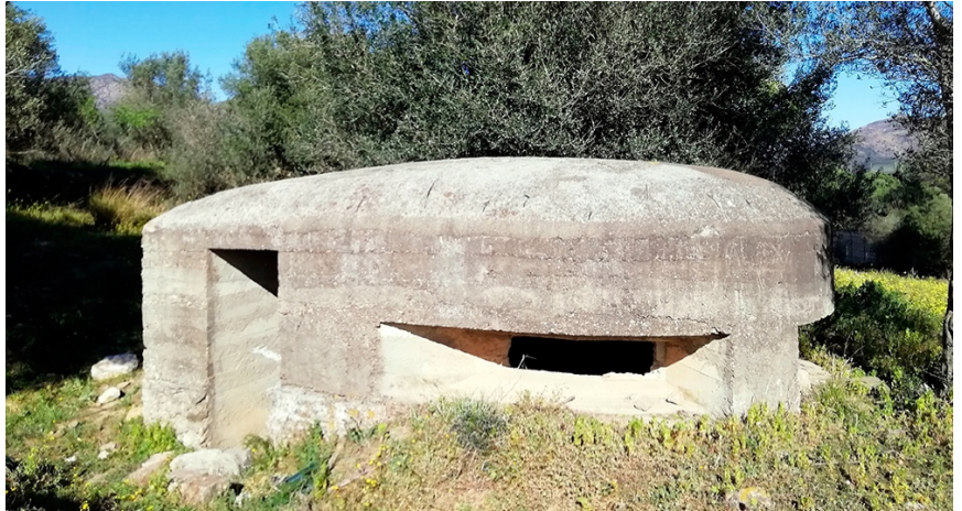
Figura 10. Niu de metralladora a Roses (Girona)
