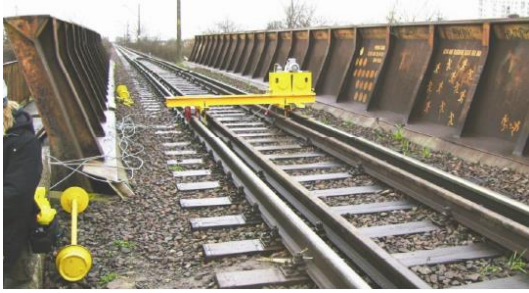
Fig. 8 Vista General de puente ferroviario con dispositivo de excitación Fuente: [84]
