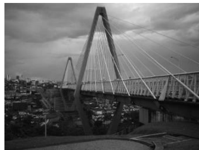
Fig. 5 Viaducto Cesar Gaviria Trujillo Fuente:[72]
