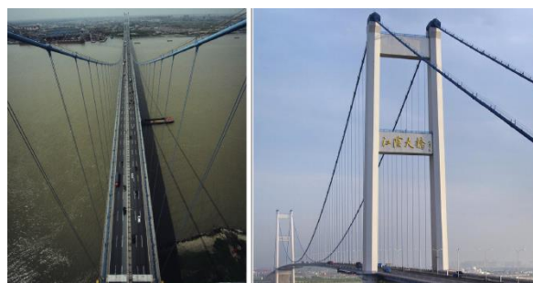
Fig. 3 Puente Jiangyin sobre Río Yangtze Fuente: [19]
