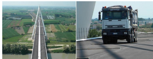
Fig. 10 (a) Vista aérea puente “Ponte sull’Adige” (b) Vehículo pasando sobre resaltos en tablero. Fuente: [88]
