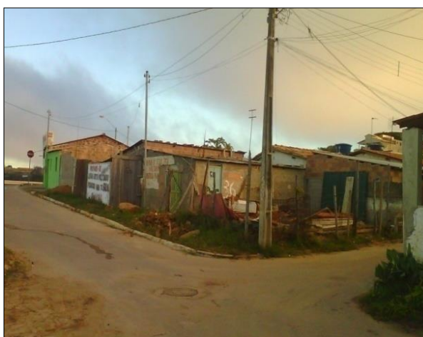
Figura 4. Moradia encontrada no Loteamento Santa Cruz em 2017
