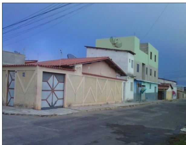
Figura 3. Moradia encontrada no Loteamento Santa Cruz em 2017
