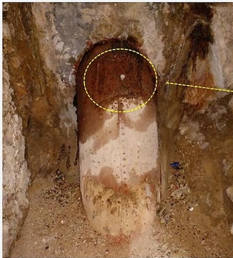
***Tubo inclinado de chapa de acero de 35 cms de Ø alojado en la cámara. Se puede observar la unión de las chapas con roblones.***
