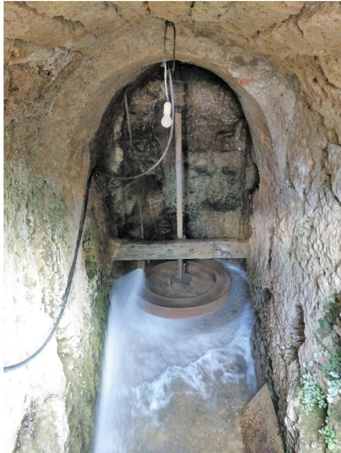
***21. Vista del rodezno en el interior del cárcavo (2)***
