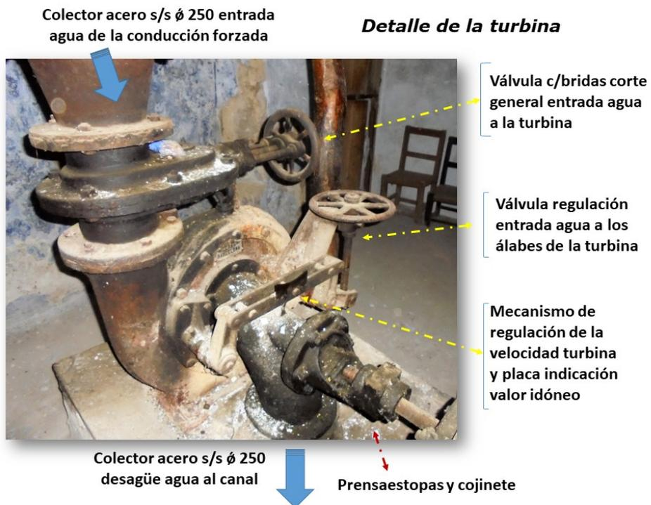
**37. Detalle de los elementos que componen la turbina (1)
