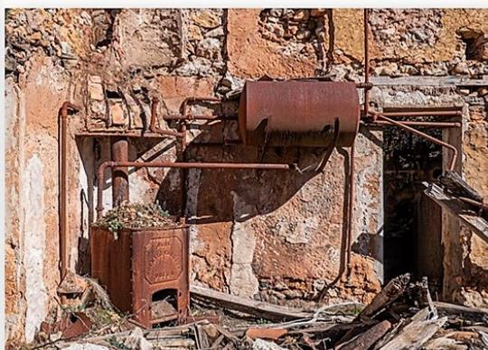
*Instalación completa: Caldera, depósito expansión - almacenaje y tuberías alimentación radiadores y A.C.S. , en la almazara de "La Cerrada" próxima a la Platera. Instalación análoga a la existente en la almazara de "Las Carmonas"*
