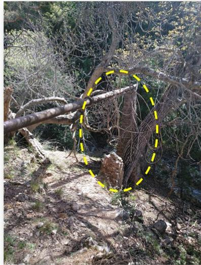
*Cruzamiento de arroyo Montero de la tubería de acero s/s 6"Ø sobre pilares de toba.*
