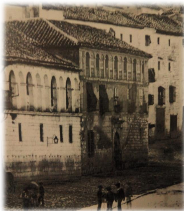
Antigua Casa de Comedias en Jaén
