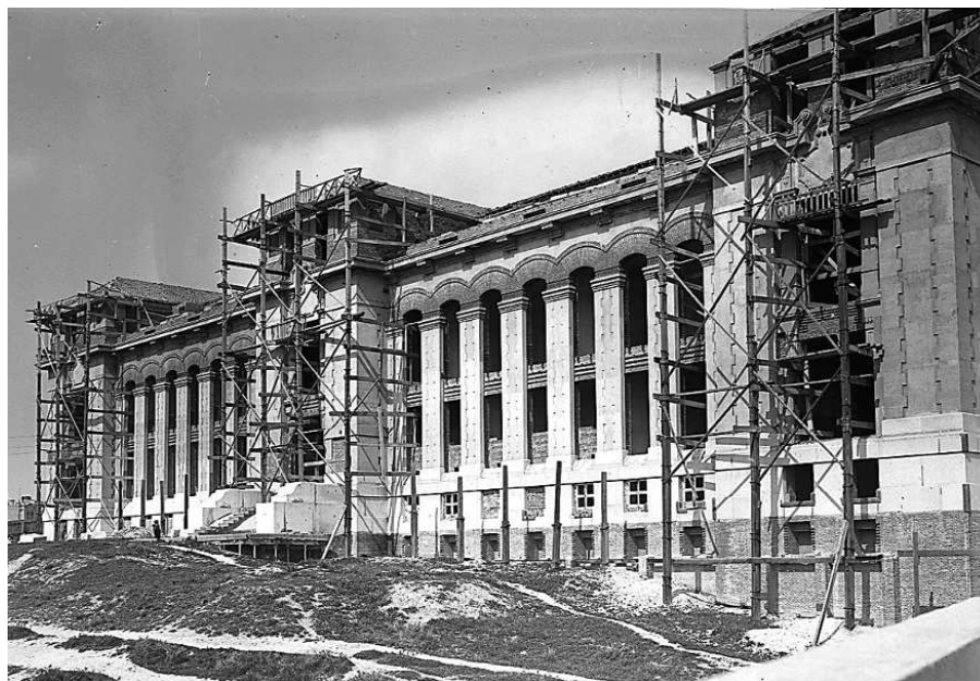
Construcción del “Instituto Cajal” en el Cerro de San Blas.
