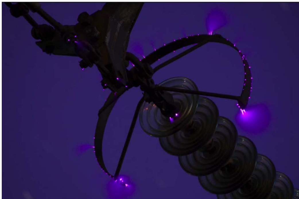
Figura 1. Anillo anticorona en una línea de 500 kV
