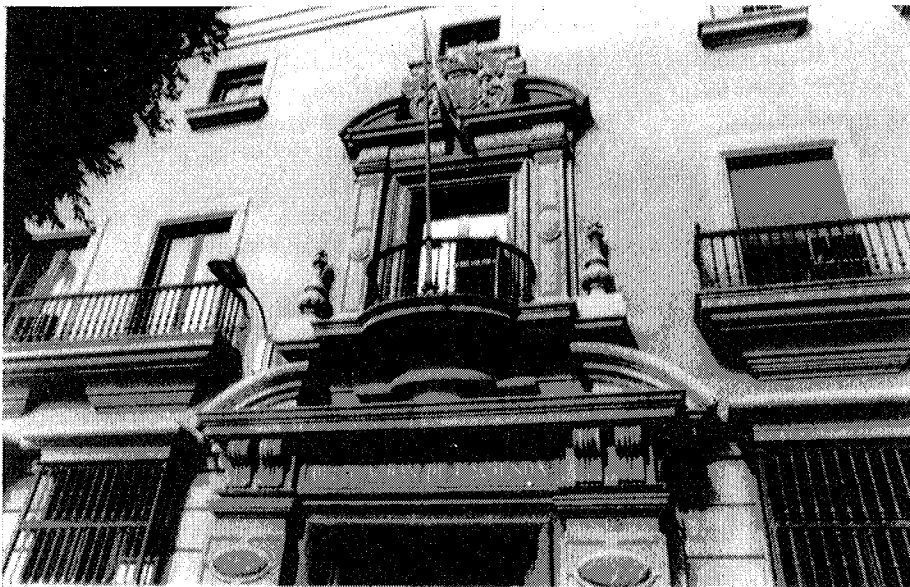
Detalle de la portada de la Delegación de Hacienda (1944) en Paseo de Almería. Arquitectos: Antonio Cámara y Federico Facci.
