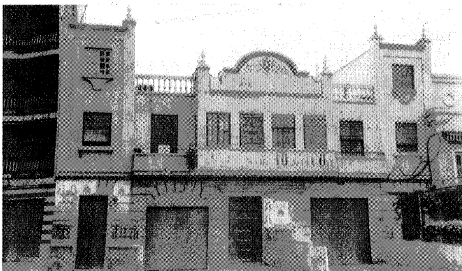
Estado actual de la vivienda.
