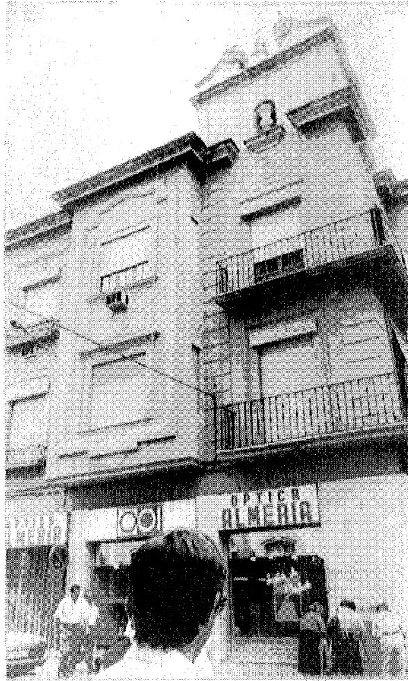
Vivienda de D. Francisco Puerta (1947) en C/. Méndez Núñez esquina a Reyes Católicos. Arquitecto: A. Góngora.
