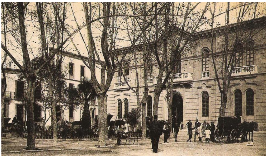
Plaza de la catedral, con el edificio del Seminario a la izquierda.
