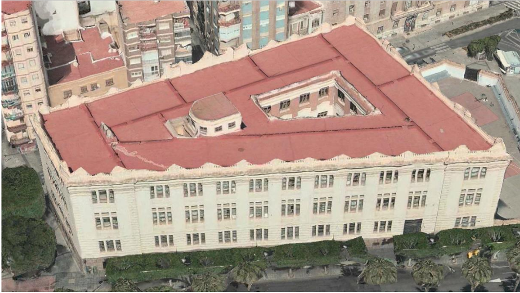
Vista aérea del edificio en su fachada posterior
