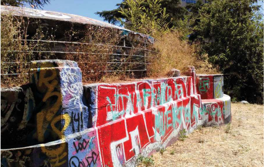
Remate exterior del óculo de la Montaña Artificial. La zona baja, cubierta de grafitis, es el basamento del desaparecido templete, que lo remataba.
