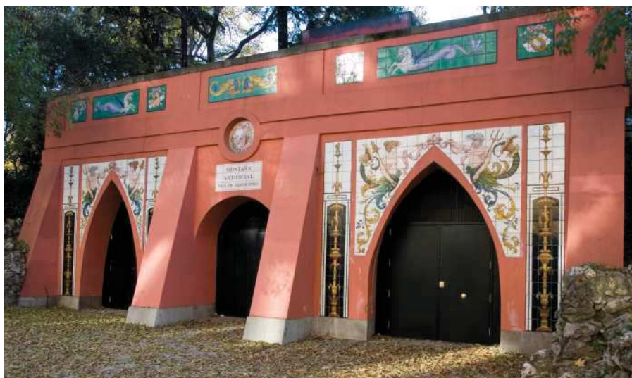
Fachada actual, situada en la cara septentrional de la Montaña Artificial.
