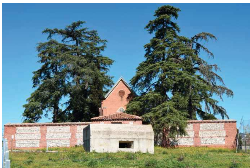
Fig. 14. Fotografía del Panteón visto desde el este y Fig. 15. Fotografía del Panteón visto desde el sur y del nido de ametralladoras.
