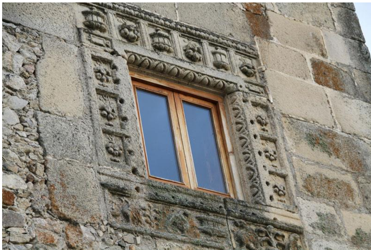
Detalle de la fachada y vanos.
