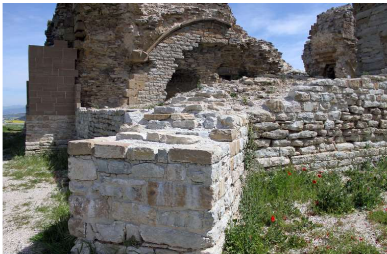
30. Contrafuerte del ángulo Oeste y módulo residencial (José Antonio Díez)
