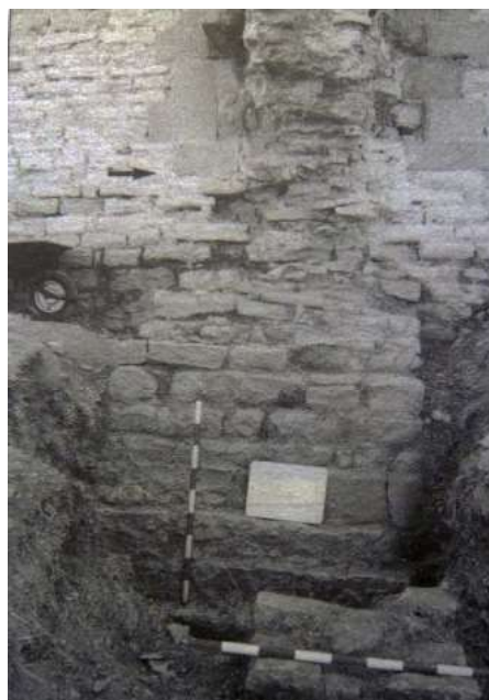
18. Excavación de uno de los contrafuertes (Amparo Castiella)
