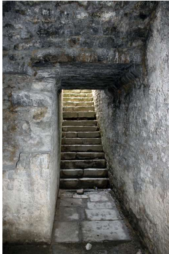
45. Escalera de bajada a la bodega vista desde el interior (José Antonio Díez)
