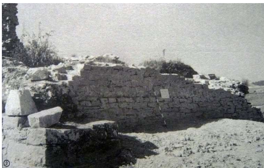
15. Excavación de la otra mitad de la cara Nordeste (Amparo Castiella)
