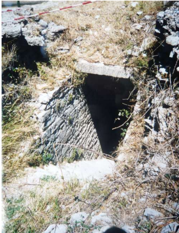
44. Puerta y escalera de bajada a la bodega (Juan José Martinena)
