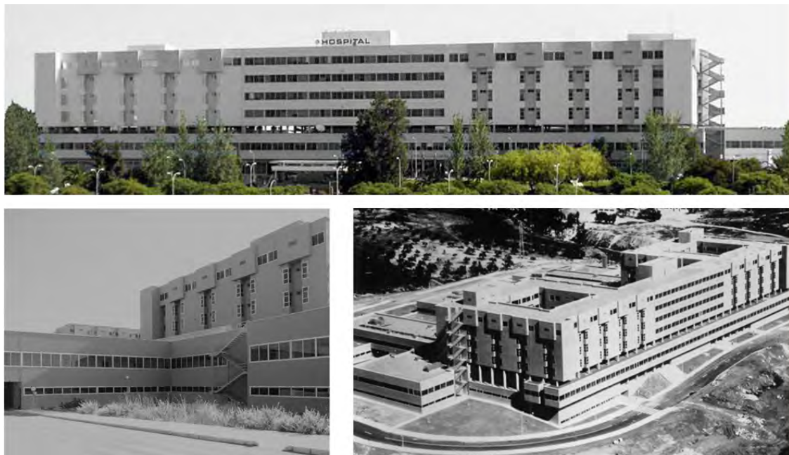
Figura 12. Hospital Clínico de Málaga.
