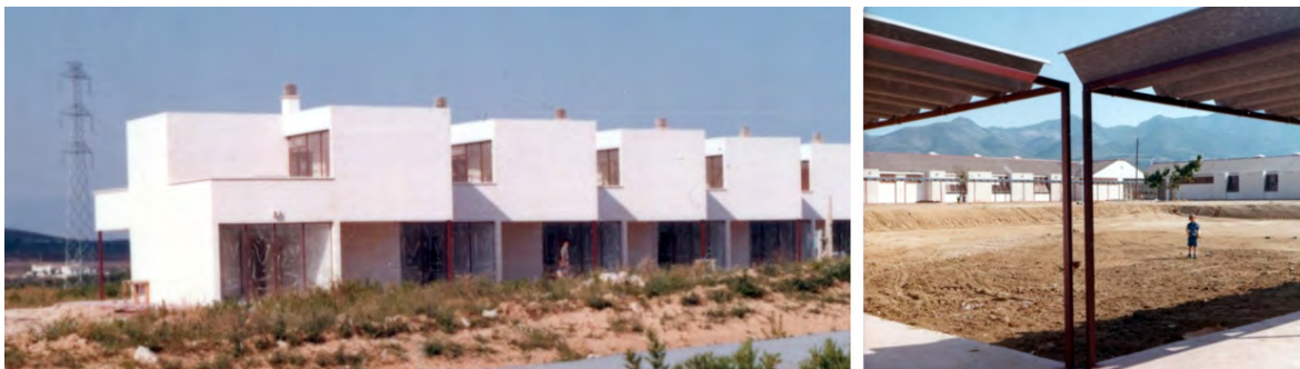
Figura 9. Hospital Psiquiátrico Alhaurín de la Torre.
