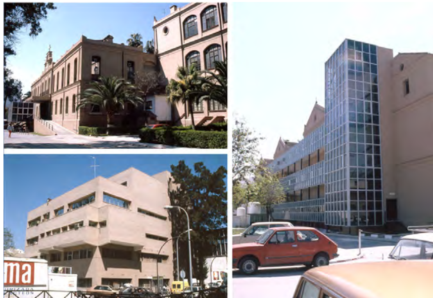
Figura 7. Hospital Civil y Centro de Transfusiones.
