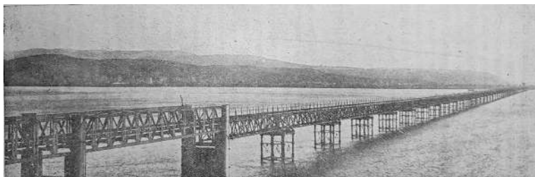
Imagen 5. Puente ferroviario sobre el río Biobío.
