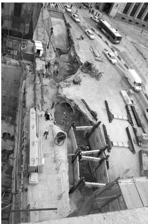
Panorámica del área de excavación.
