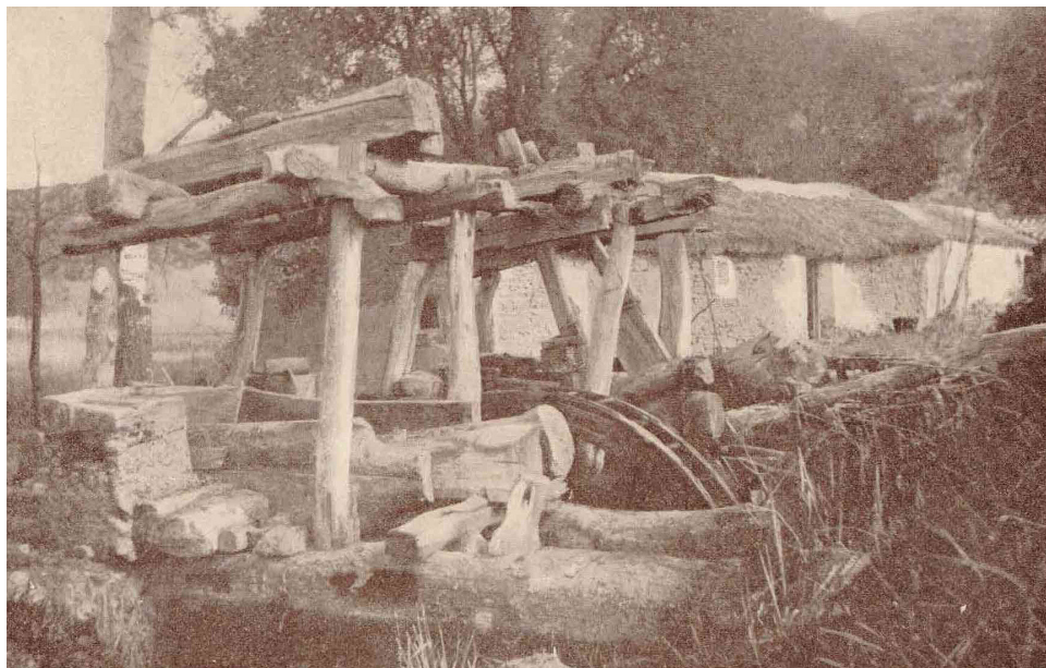
Fig. 6: Maquinaria del batán de la Zarza, situado en las cercanías de Ruidera. Fuente: La tierra de don Quijote , Revista Blanco y Negro, 6 de mayo de 1905.
