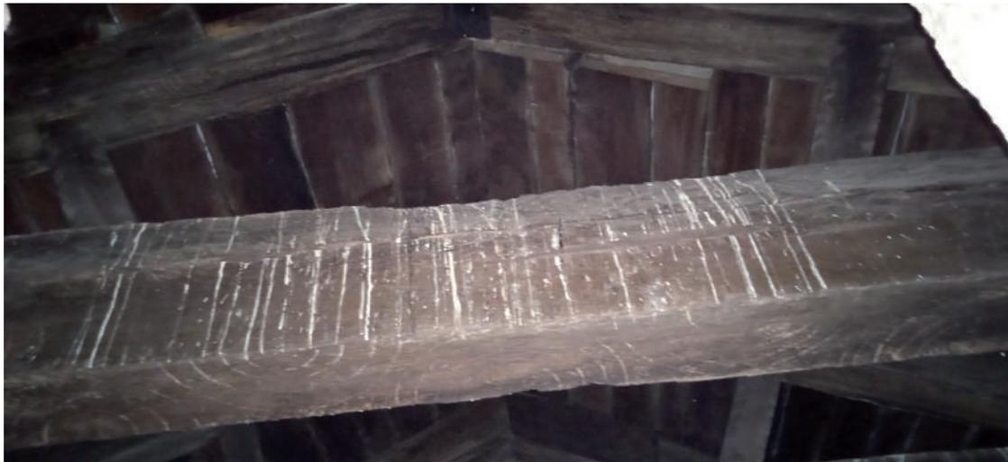
Figura 5: Cercha original en la cámara del tesoro de Priesca. Véase la decoración de círculos concéntricos en el canto del tirante y de la tijera izquierda, así como las tornapuntas con puntas de diamante. Foto: Julio César Zapico
