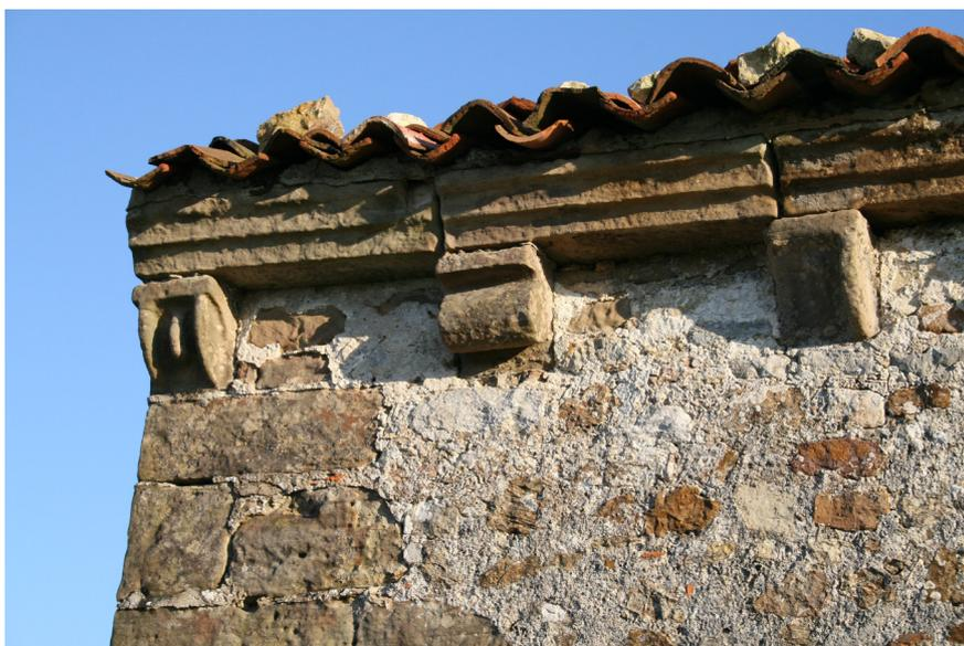
Fig. 3: Detalle de los canecillos del ábside.
