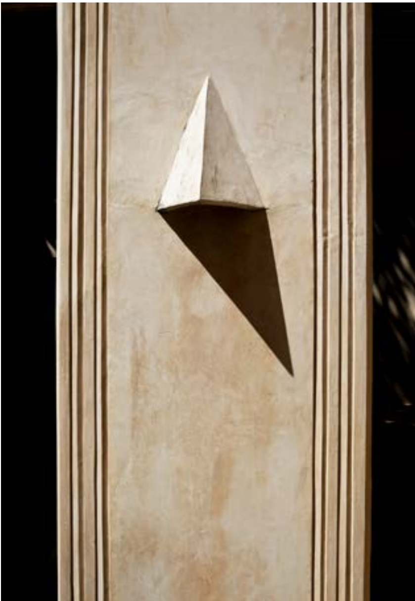
Lighting detail | Detalle de la iluminación | Pormenor da iluminação
