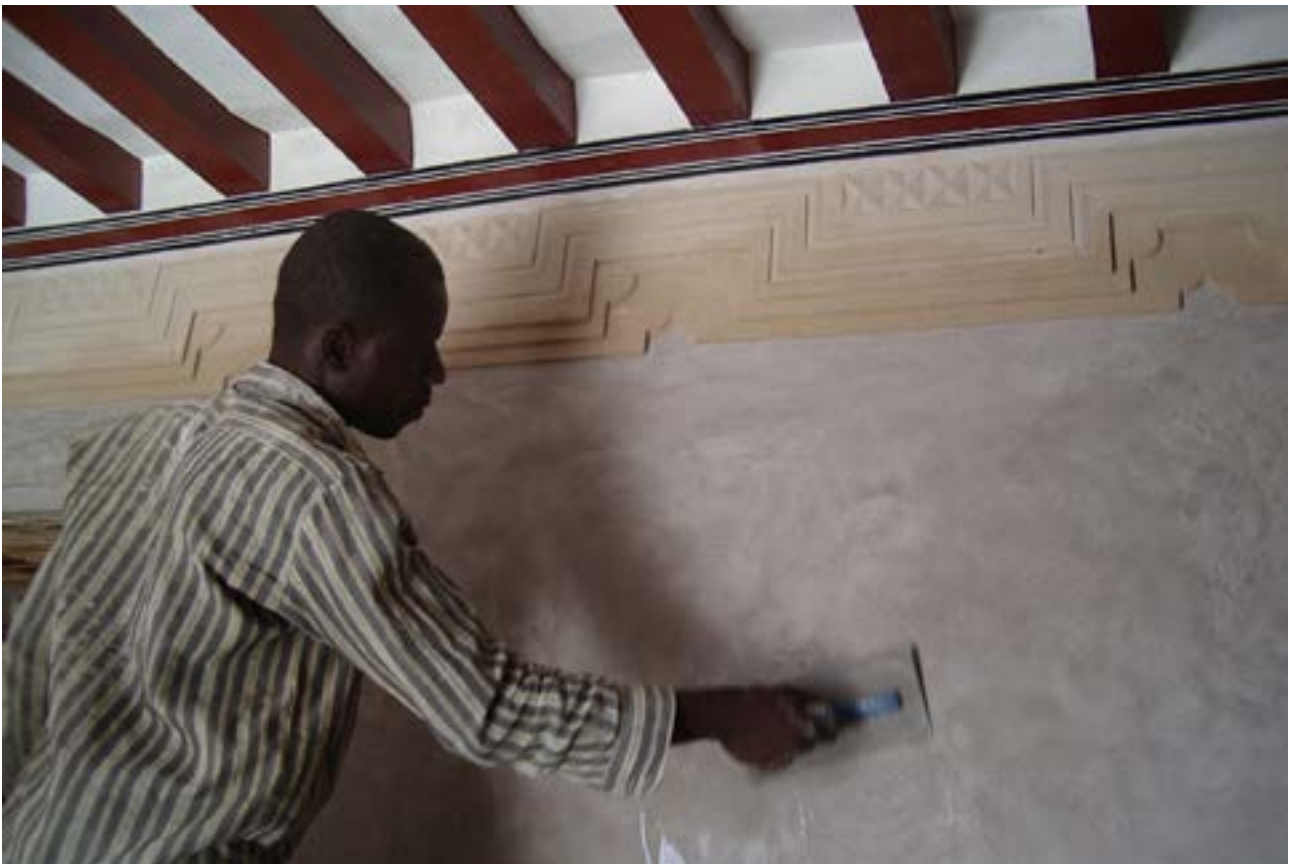
Craftsman applying stucco ( nyeru ) | Artesano aplicando estuco ( nyeru ) | Artesão a aplicar estuque ( nyeru )
