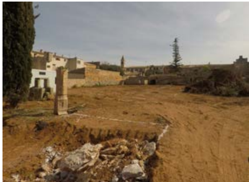
Previous state of the plot and staking out at the start of building work | Estado previo de la parcela y replanteos al comienzo de las obras | Estado pr vio da parcela e traados no in cio das obras
