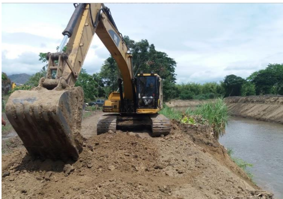
Figura 4. Ejemplo de trabajos de limpieza y re-conformación de cauces de ríos de Manabí. Fuente: (GADPM, 2018).
