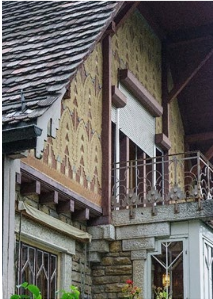
Figure 16. Charles-Édouard Jeanneret (Le Corbusier), Villa Fallet, 1906-7, La Chaux-de-Fonds (TB dsc02256)
