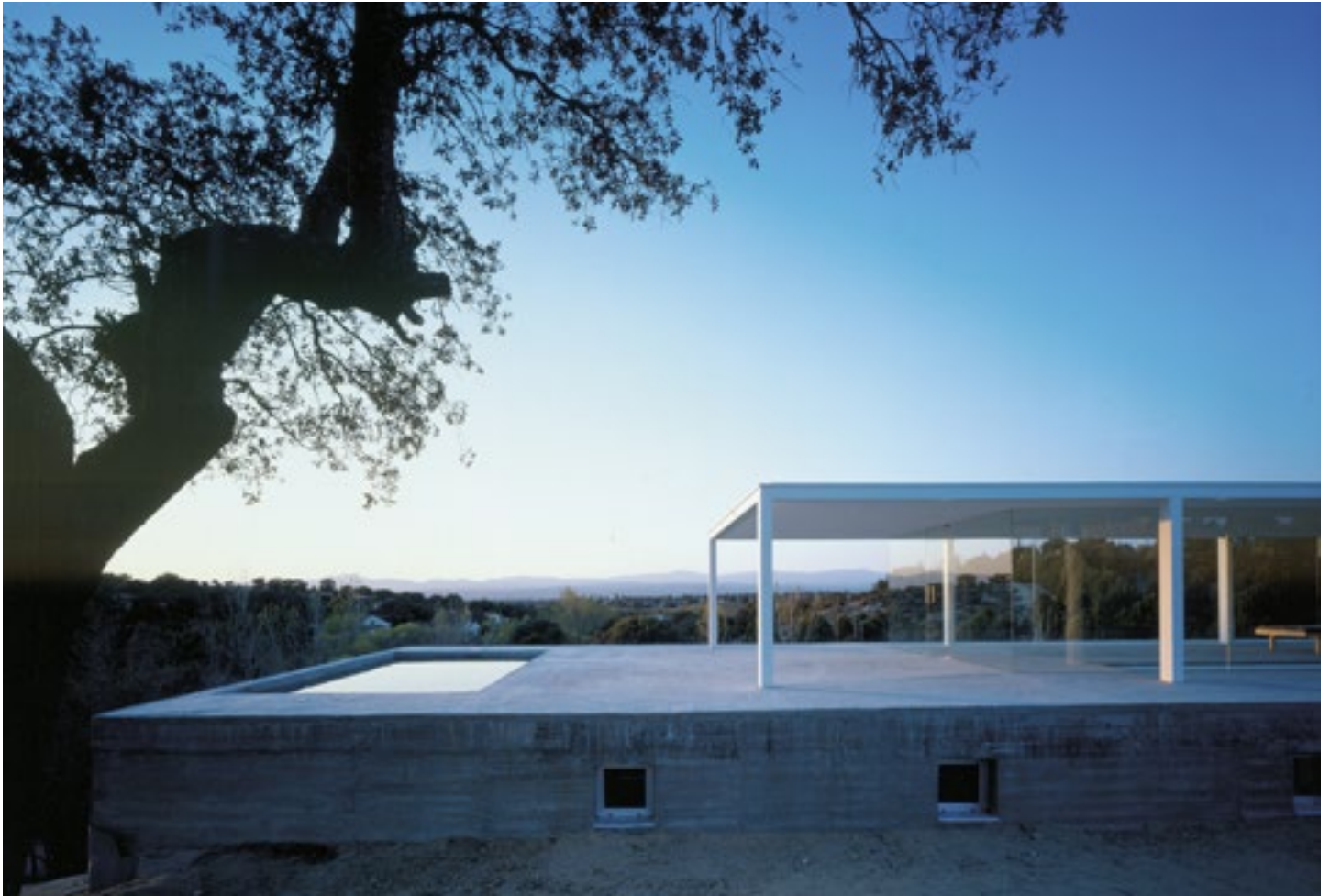
Imagen 9. Casa de Blas, Madrid. 2000 / De Blas House, Madrid. 2000.
