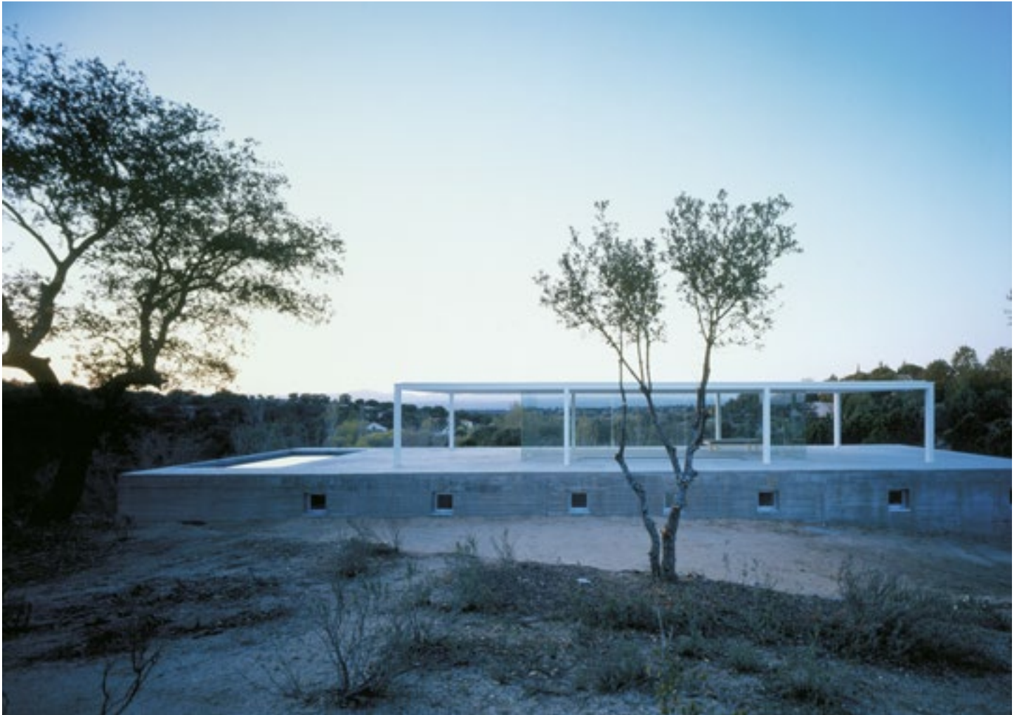
Imagen 7. Casa de Blas, Madrid. 2000 / De Blas House, Madrid. 2000.
