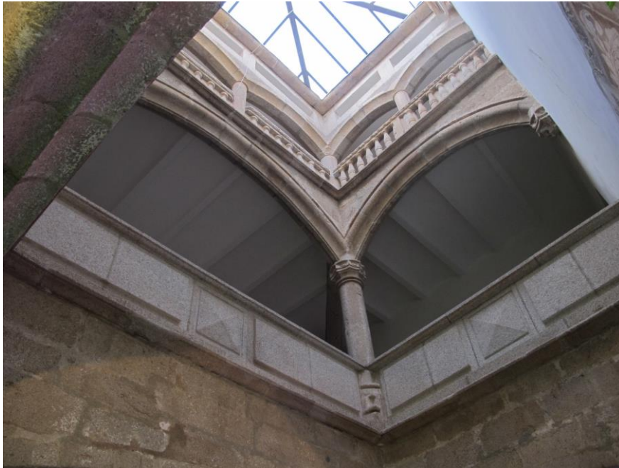
Figura 11.- Detalle del patio clausturado
