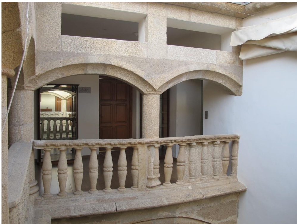
Figura 9.- Patio interior, detalle
