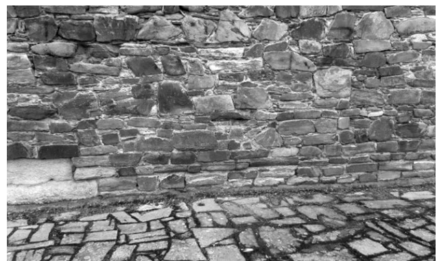
23. Diferencia de aparejos en la parte baja de la muralla adosada al depósito.
