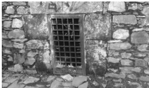
17. "Ventana" que da al interior del depósito.
