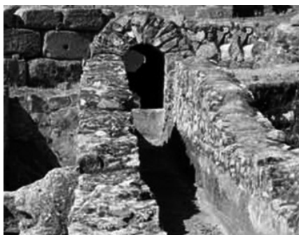
21. Murete que reduce la velocidad y eleva el nivel de la lámina de agua para facilitar su derivación al canal de la derecha (Consorcio Ciudad Monumental de Mérida: https://www.consorcio-merida.org/conjunto/monumentos/piscinalimaria ).
