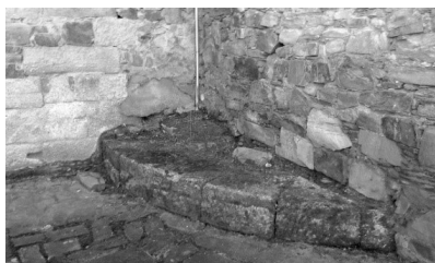
15. Arranque del cubo que está a la derecha del depósito.
