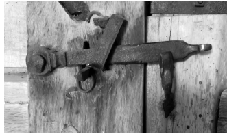
Picaporte, parte interior. Foto del autor.
