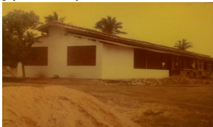
Figura 04 - Um dos galpões construídos para sediar as aulas-oficinas de serralharia e marcenaria.
