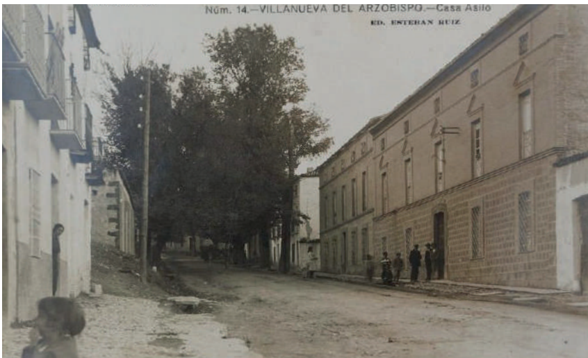
Asilo-hospital de los Ancianos Pobres y Desamparados.
