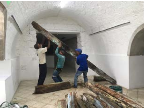
Figura 4. Colaboración por parte de profesionales que se dedican a la demolición de edificios en Guayaquil para la instalación de la obra Levedad . Galería Mirador UCSG. 2019.
