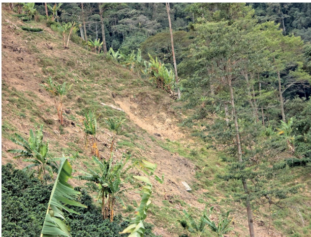
Figura 5. Erosión del suelo con deslizamiento localizado en g1. Vereda El Rubí, Ibagué. Fotografía de Montes, noviembre de 2012.
