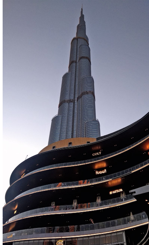
Figura 2. Burj Khalifa. Fotografía de Avendaño Arias, febrero de 2020.
