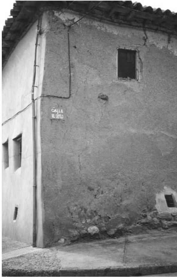
Foto 8. Villafrechós (Valladolid). Calle del Castillo.
