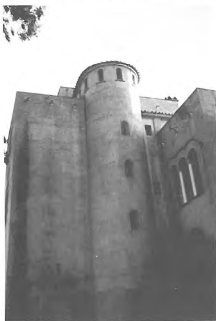
14. Vista de la Torre noroeste junto a la Fachada principal.
