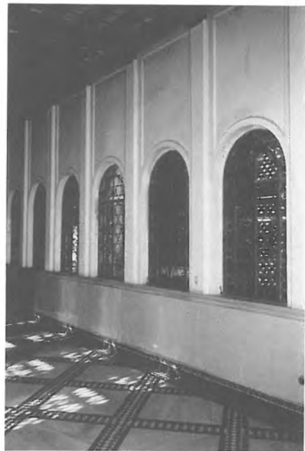
18. Galería de la planta primera con arcada a las fachadas Norte y Sur.
