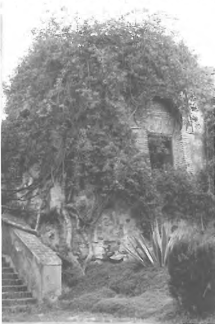
5. Estado actual de la Torre Oeste de Santa Catalina.
