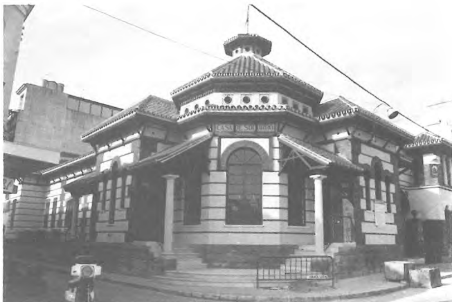
15. Casa de Socorro, estado actual.
