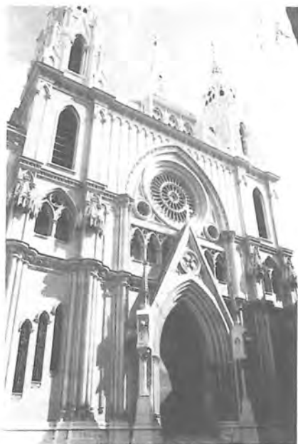
7. Fachada de la iglesia del Sgdo. Corazón.
