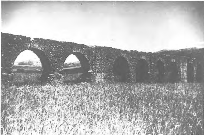
Lám. 6: Acueducto de Ronda.
