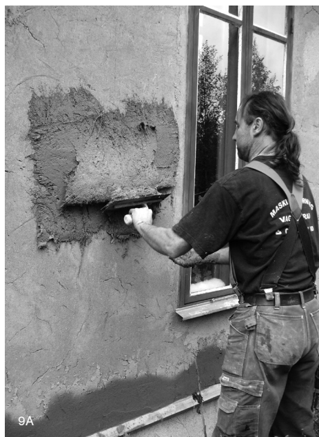
Figuras 9A y 9B: Oficina con revoque de tierra, en Vekhyttan, Suecia. Fuente: (Correia, 2010).
