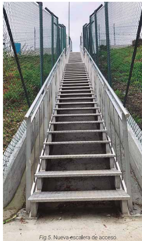
Fig. 5. Nueva escalera de acceso.
