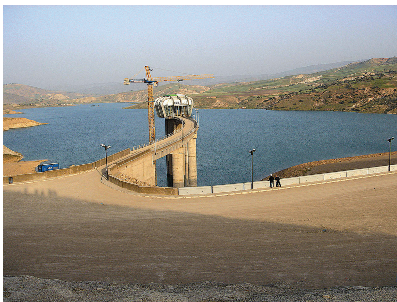
Figure 5. Barrage Kramis construit en 2005
