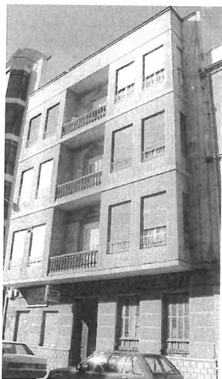
13.- Calle Duquesa de la Victoria nº 24, arquitecto Enrique Nieto
