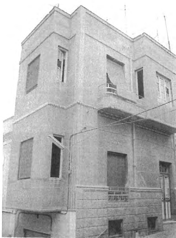
15.- Calle Sagasta nº1, arquitecto Enrique Nieto
