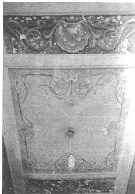
8.- Salinas, 10. Pinturas techo portal.
