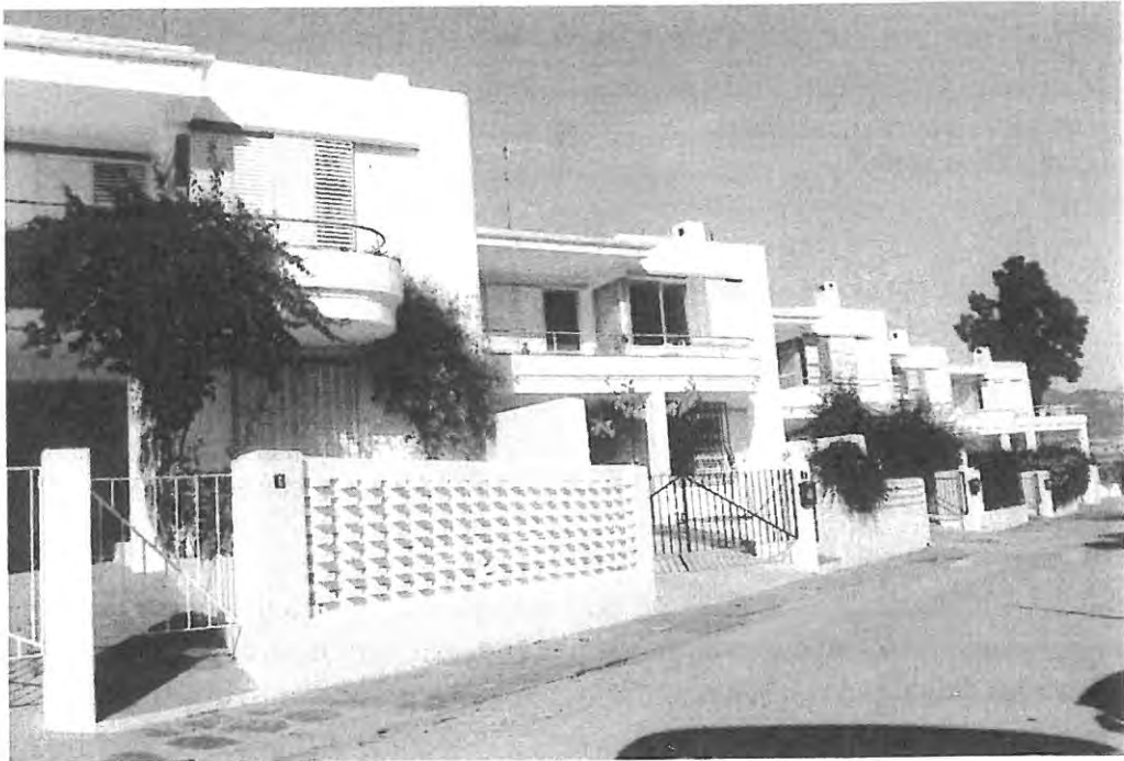
11.- Viviendas adosadas del complejo Aldea de las Águilas. Guadalmina Alta.
